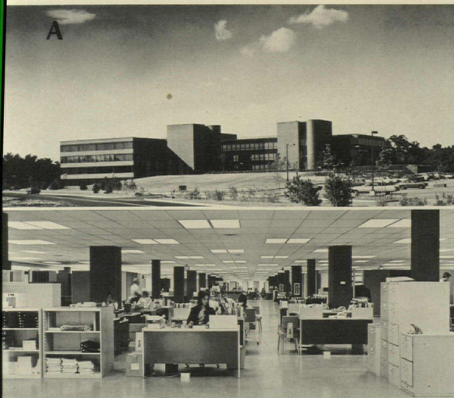
Lawrence S. Williams, Inc. photos
