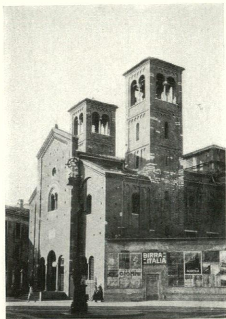
Fig. 6. S. Sepolcro , Milan—the Restored Façade
